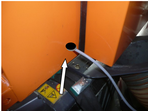
Steuerkabel der wegeabhängigen Steuerung
